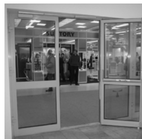
Противопожарные двери (EI 60)
