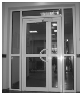
Противопожарные двери (EI 45)
